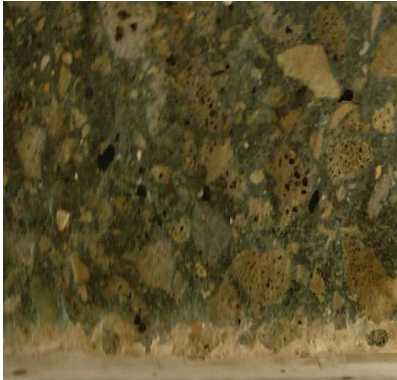
Figure 6.16 : béton basique à base de granulats de laitier.
