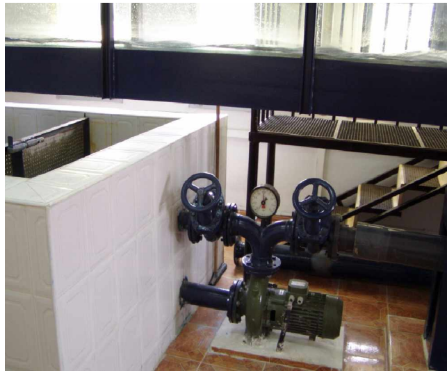
Photographie 4: Vue de la pompe axiale utilisée insérée dans la conduite circulaire à l'aval du bassin de récupération des eaux
