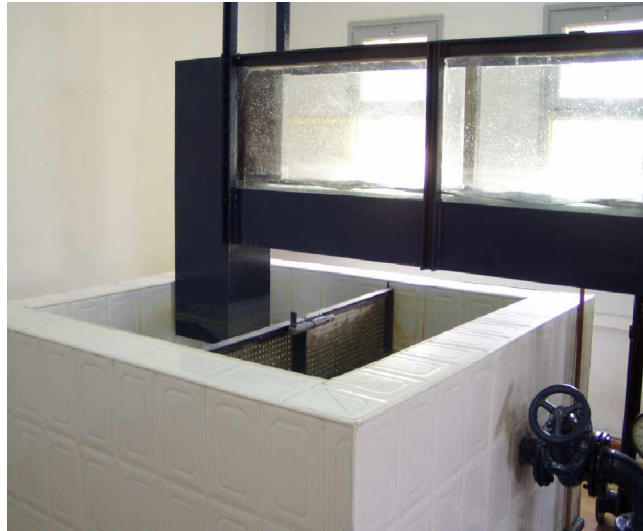
Photographie 3 : Vue de la partie aval du canal de mesures, montrant : Le réservoir de récupération des eaux, - la grille perforée de tranquillisation, – la vanne de réglage des débits.
