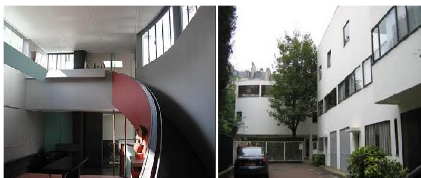
Fig -I.9 - vues intérieures et extérieures de la villa " La Roche " de Le Corbusier Source : Cohen. J-L, 2004
