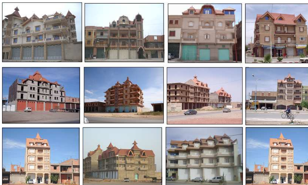
Fig – 0.1- Les " Diar Charpentii ": une architecture domestique du Plouf Source : clichés de l'auteur, 2008
