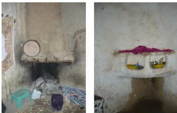
Fig –VII.22- Cheminées dans les "Diar Be reboe" à Magra et à Berhoum Cliché de l'auteur, 2009
