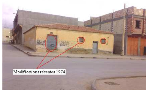
Fig –VII.21- "Dar Berbou" à Magra après modifications sur façade Cliché de l'auteur, 2009
