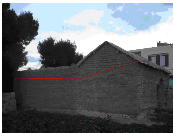
Fig-VII.18- " Dar sathi " à Magra datant de 1948 transformée en " Dar Kraib " en 1963 Source : cliché de l'auteur, 2009
