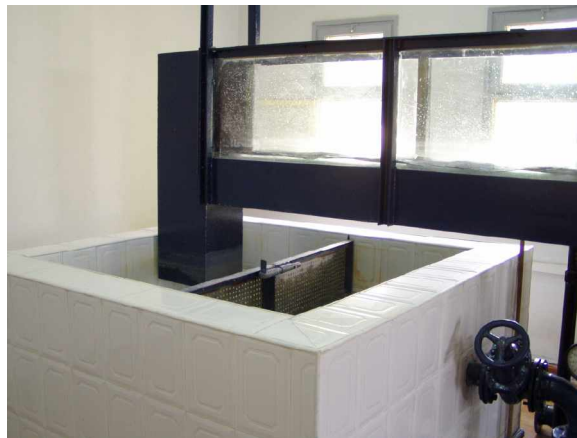
Photographie 3.2 : Vue de la partie aval du canal de mesures, montrant : le réservoir de récupération des eaux, - la grille perforée de tranquillisation, - la vanne de réglage des débits.
