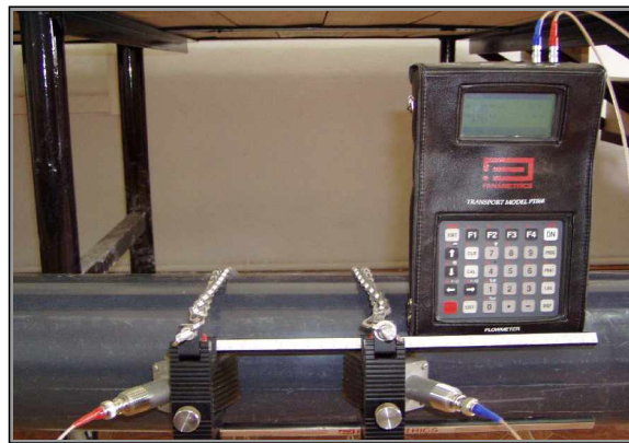
Photographie 3.6 : Vue du débitmètre à ultrasons inséré dans la conduite d'alimentation du canal de mesures.
