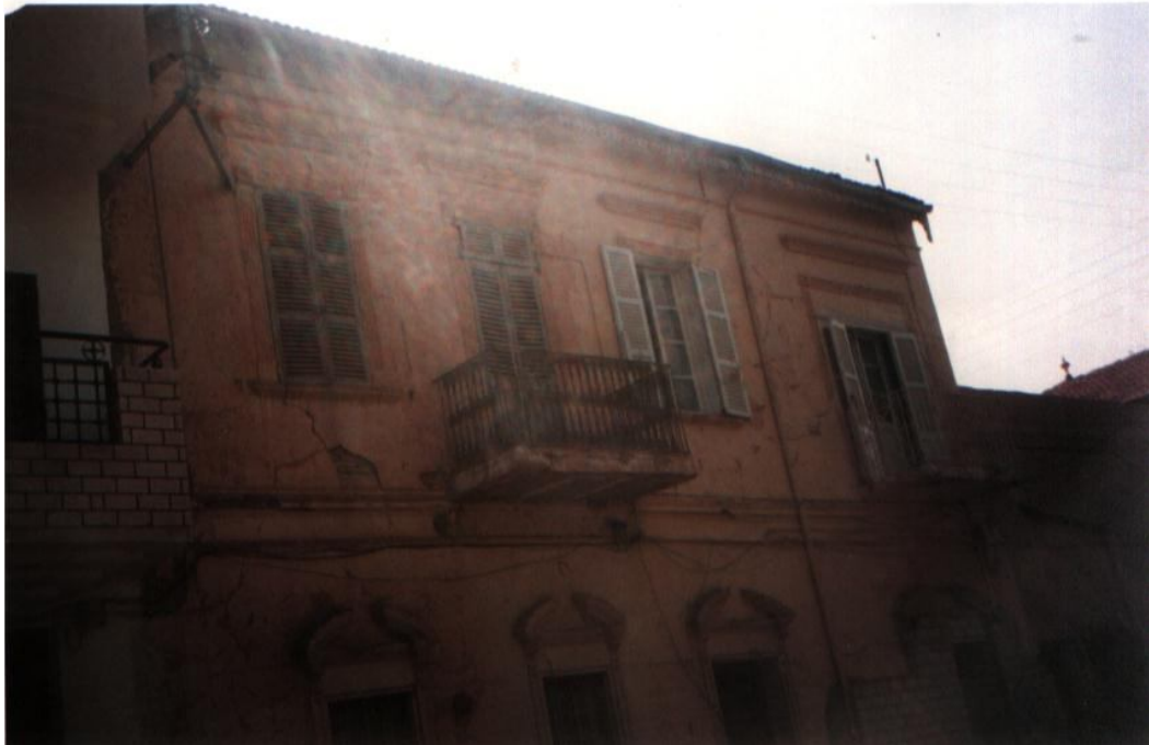
Photo N°: 3.1. 1 Construction coloniale (volonté d'exprimé l'aspect occidental de la part du colonialisme
