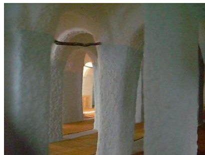
B/ Vue sur les rangées intermédiaires de salle de prière.
