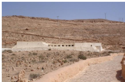
Figure.6.25. Mausolée Ba M'hamed_ Vue de l'extérieur. (Auteur)
