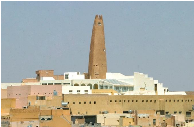
Figure. 6. 9. La Grande mosquée de Ghardaïa. (Source : Auteur)
