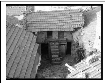
Photo 3.3: Maison Kabyle de Ait Aissi; l'introduction de l'étage (Source: flickr.com)
