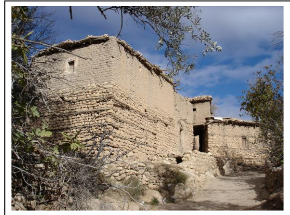
Photo 5.3: Une maison à terrasse plat (Source: Httena, 2009)
