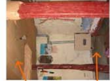
Couverture du plafond avec du plâtrique et du carton
