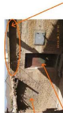
Crépissage du mur de façade avec un mortier de ciment
