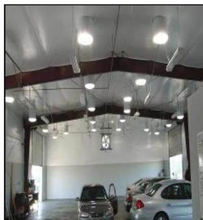
Figure 84 : Vue intérieur d'un puits de lumière. (Source: <http://www.natureetconfort.fr>)
