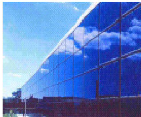
d) : la pose en façade intégrée
