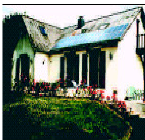
b) : la pose par dessus-la couverture classique
