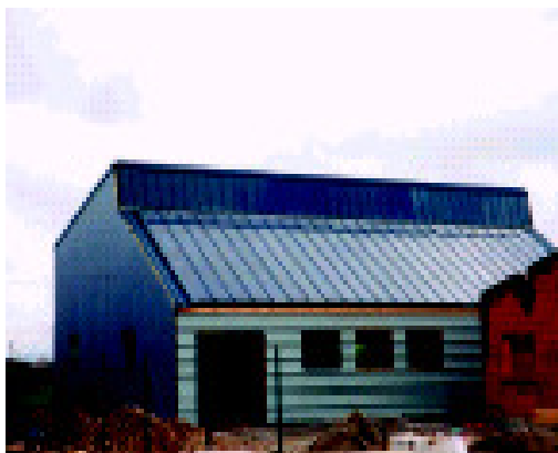
c) : la pose en couverture intégrée
