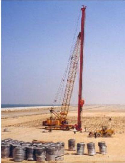
Figure II.15 : Drains verticaux.
