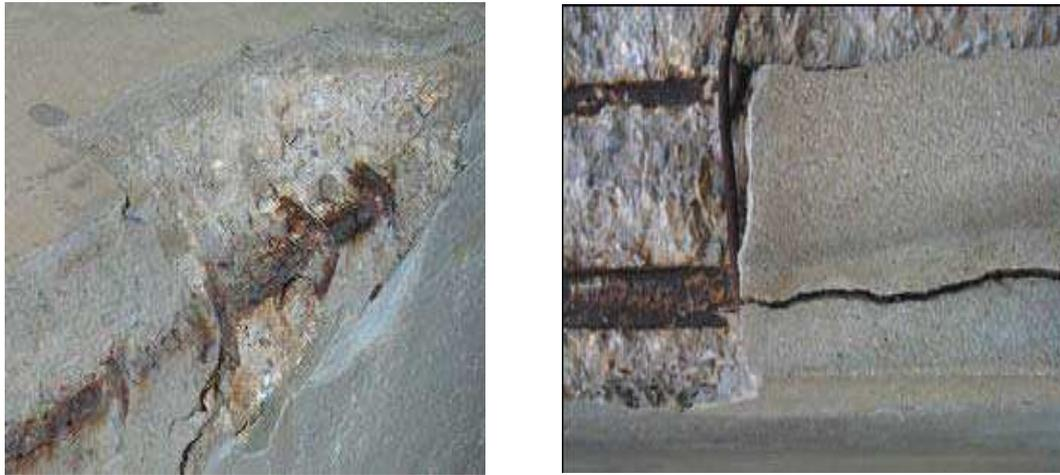
**Figure 2.1** : Exemples de corrosion par carbonatation [90].
