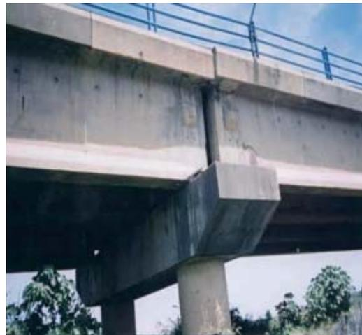
Figure 2.5 : Déplacement latéral et longitudinal du pont d'Isser (Boumerdes, 2003)
