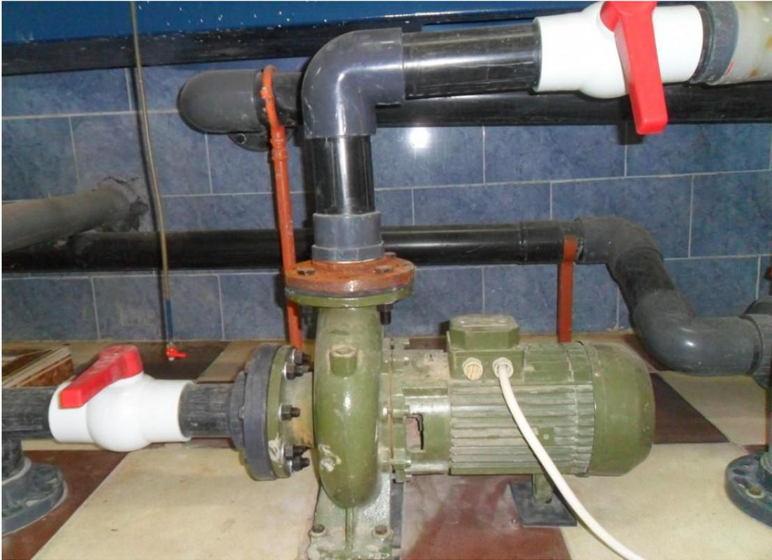
*Figure 1.4 : Deuxième pompe (pompe de renforcement)*
