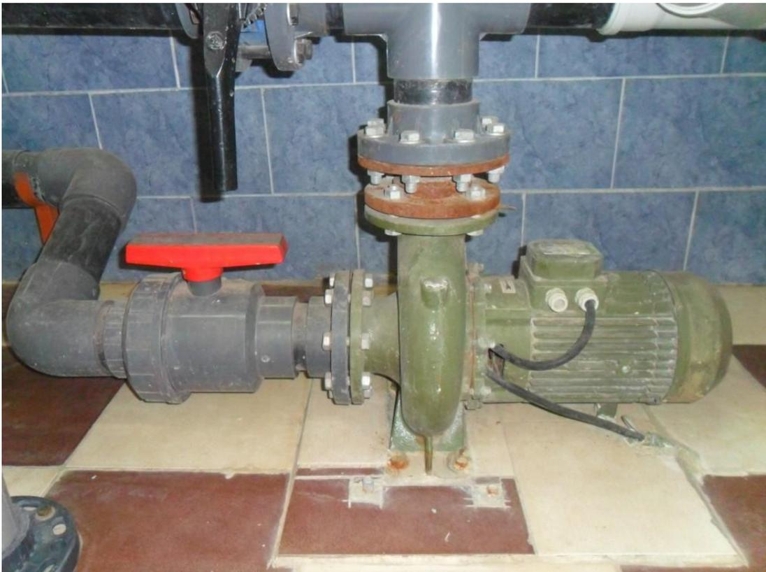
*Figure 1.3 : Pompe centrifuge axiale (pompe principale)*
