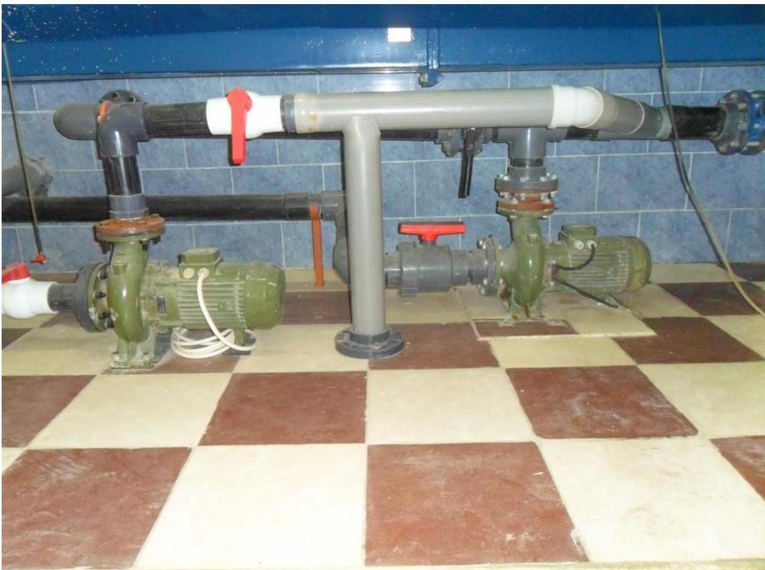
*Figure 1.5 : Raccordement des pompes*
