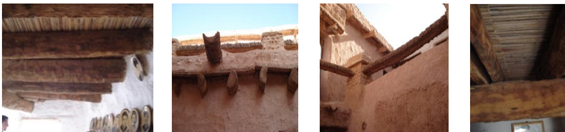
Figure 4.12 : le multiple usage des stipes (poutres, évacuateurs, clôture, Faux-plafond)
