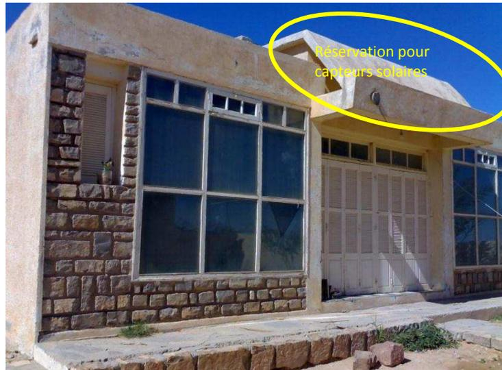
Photo (II-I-13)- mur trombe, et réservation pour capteurs solaires.
