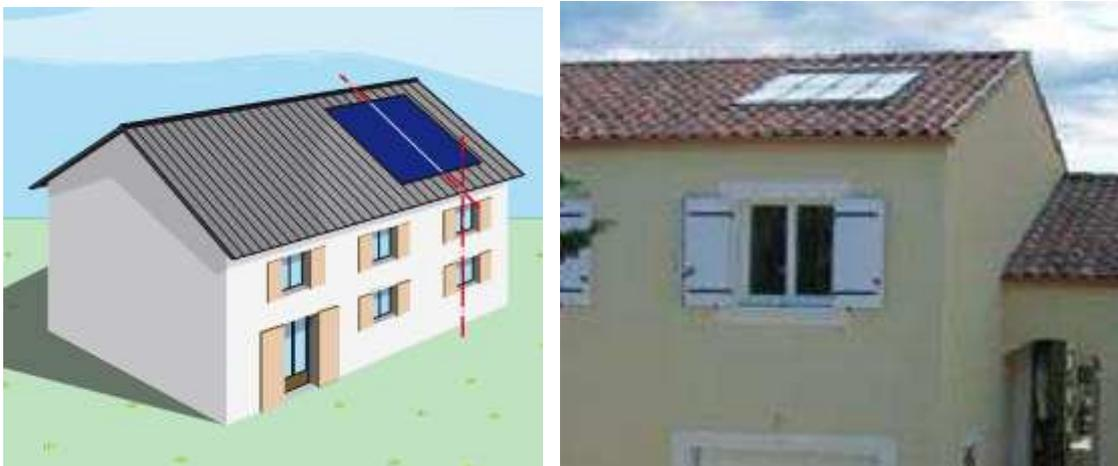
Fig. (I-III-5)- installation du capteur sur une toiture inclinée respectant l'axe de la fenêtre.
