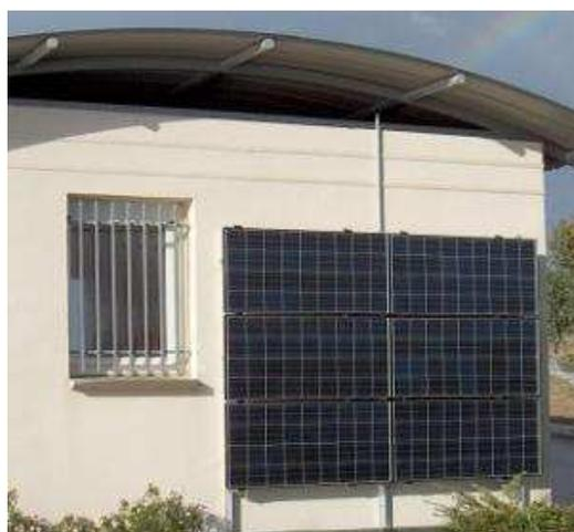
Fig. (I-III-15)- intégration des capteurs solaires sur les allèges.
