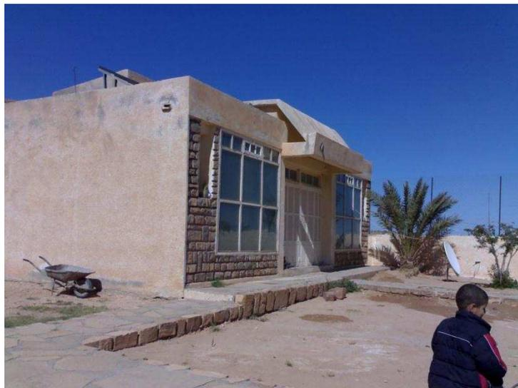
**Photo (II-I-10)**- vue du côté Sud, définition de 3 espaces : le séjour familial avec la serre au centre et les chambres de part et d'autre avec leurs ouvertures et mur trombe.
