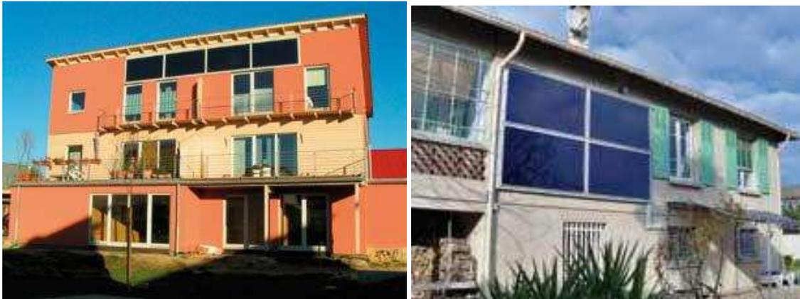
Fig. (I-III-20)- exemple d'installation des capteurs solaires sur la façade comme composant architectural.
