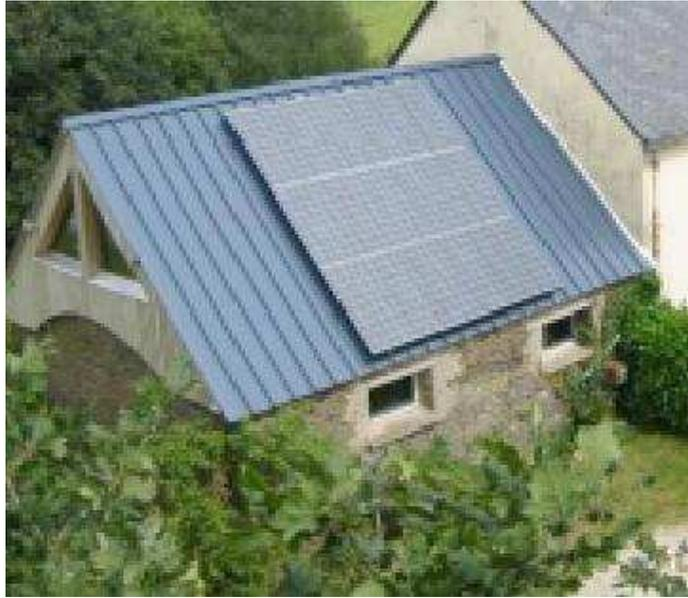
**Fig. (I-III-9)**- intégration du capteur sur une partie de la toiture en pente du bâtiment.
