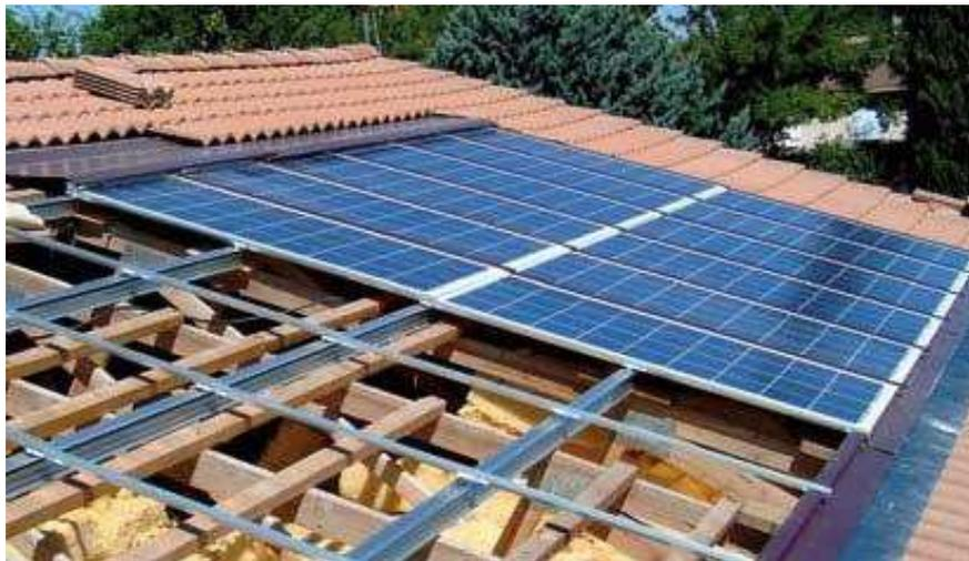
**Fig. (I-III-12)-** modes d'intégration du capteur sur une partie d'une toiture en pente.
