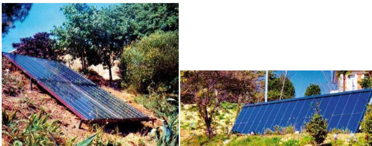
Fig. (I-III-25)- installation des capteurs solaires sur le sol.
