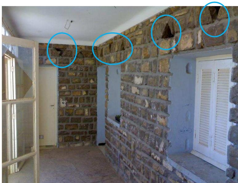
**Photo (II-I-5)-** la serre avec les orifices de ventilation pour les chambres.
