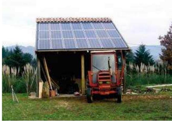
**Fig. (I-III-27)-** exemple d'installation des capteurs solaires sur une dépendance.
