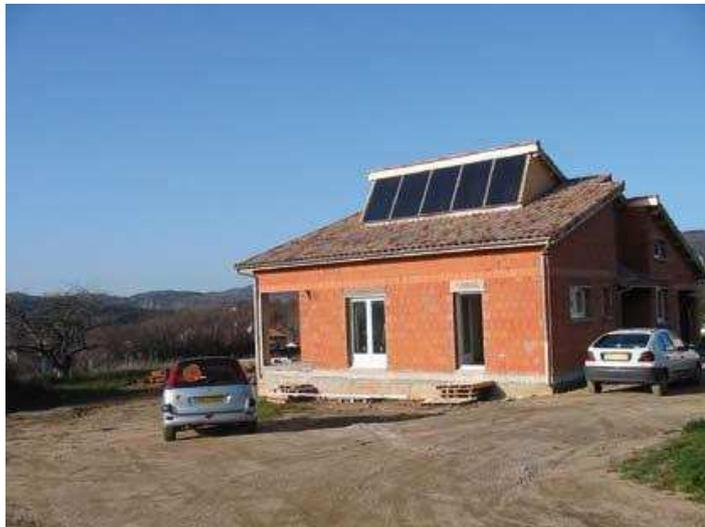
**Fig. (I-III-10)**- intégration du capteur sur une toiture en pente d'un volume du bâtiment.
