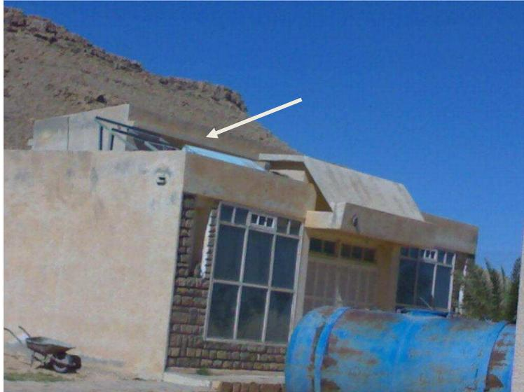
**Photo (II-I-11)**- ouvertures en hauteur, pour captage solaire au séjour.
