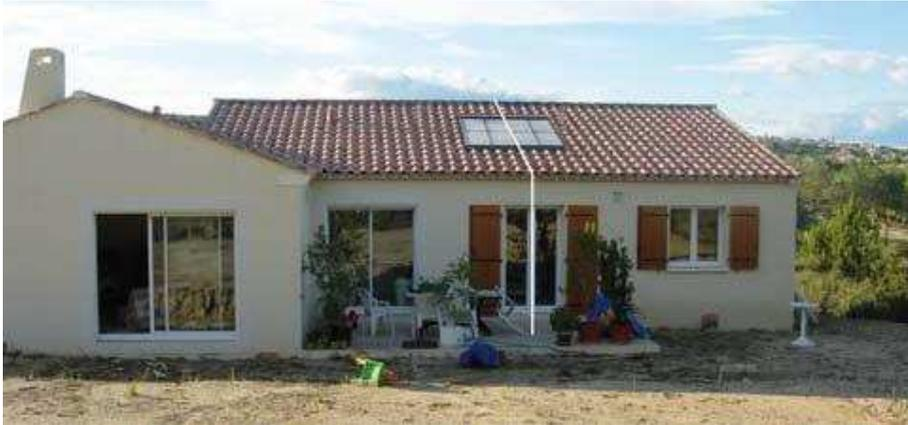
Fig. (I-III-6)- intégration du capteur sur une toiture inclinée respectant l'axe de l'ouverture.
