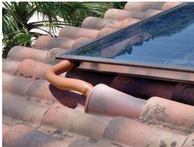
**Fig. (I-III-11)**- intégration des systèmes et accessoires du capteur sur une toiture en pente.
