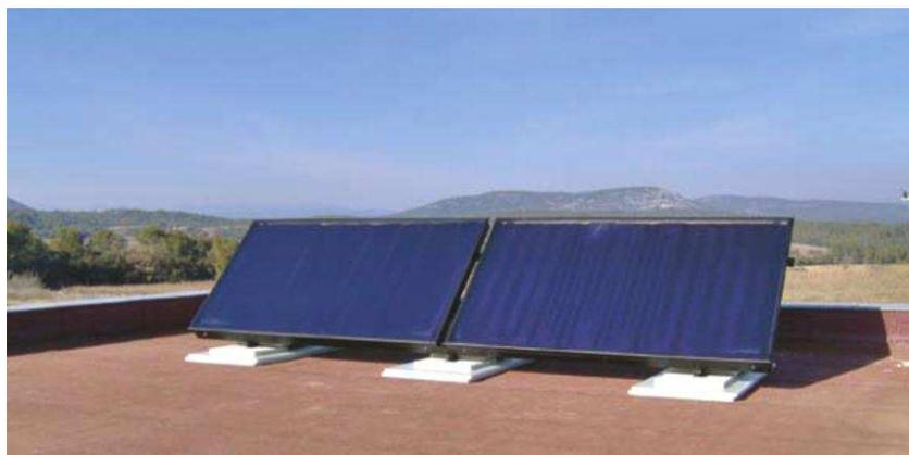
**Fig. (I-III-19)**- exemple d'installation des capteurs solaires sur une toiture terrasse.
