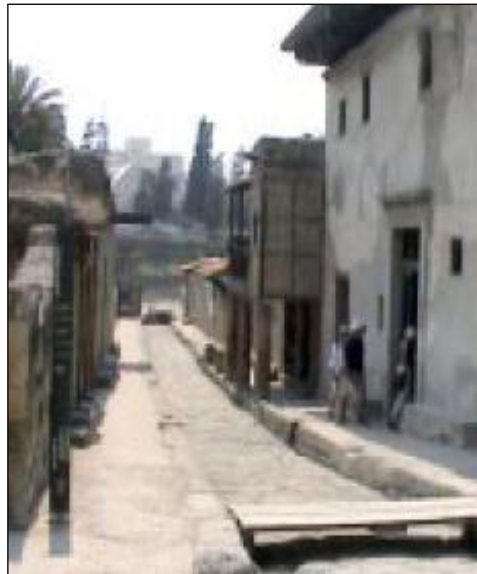
Figure, II.6 : rue d'Herculanum Exemple d'utilisation des planches pour se protéger des eaux de pluies Source : Encarta, 2005
