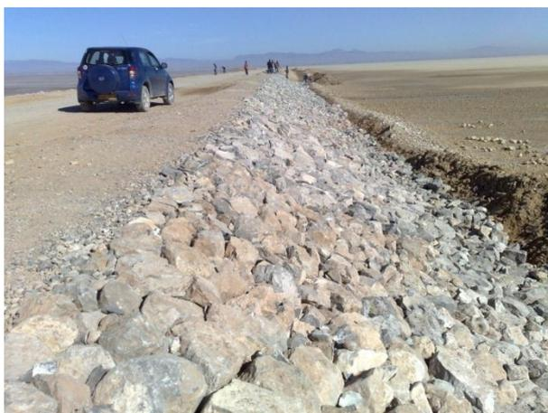
**Figure 4.27** Visualisation de la deuxième couche d'engrochement de 20 à 30 cm
