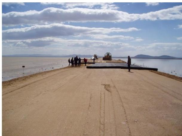
**Figure 4.20** Illustration de la surface plane avant la pose de géogrille
