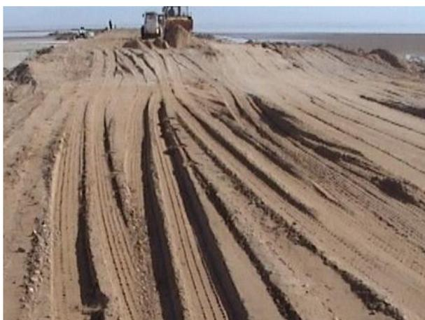
**Figure 4.15** Illustration de difficulté d'avoir une surface plane de la couche du remblai
