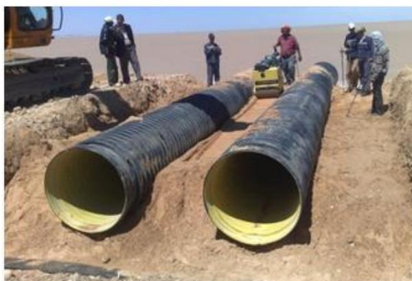
**Figure 4.23** Compactage du remblai contigu aux tubes
