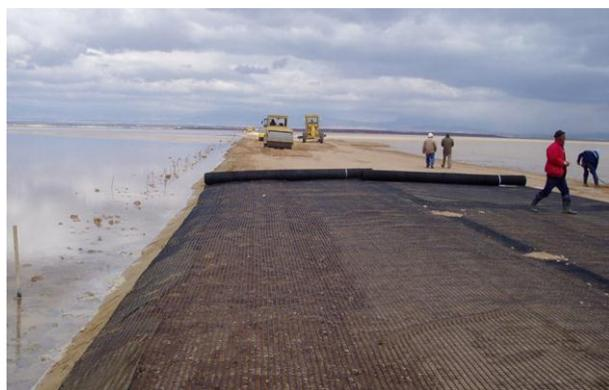
**Figure 4.21** Mise en place de nappe de géogrille
