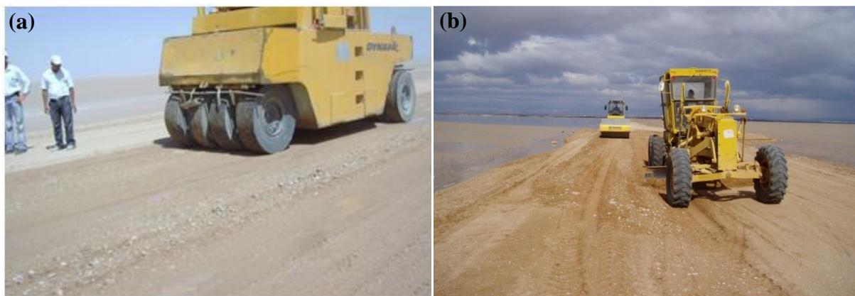
**Figure 4.22** Compactage des couches de remblai : (a) compactage pneumatique ; (b) compactage cylindrique
