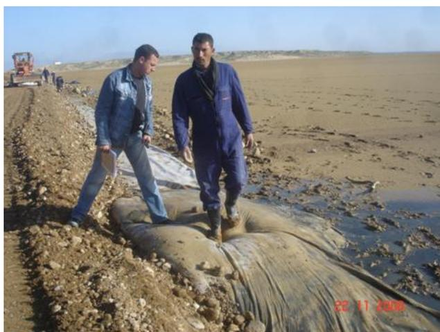
**Figure 5.3** Remblai sur zone faible localisée
