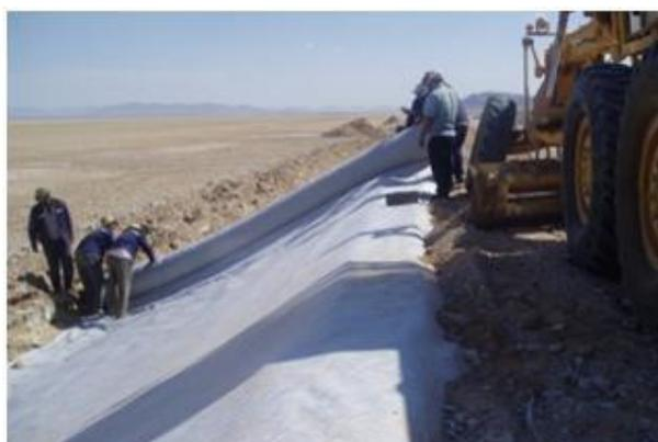
**Figure 4.24** Visualisation du déroulage et enclage en tête du géotextile sur les talus
