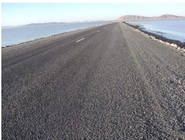
**Figure 4.29** Couche de roulement en enduit superficiel
