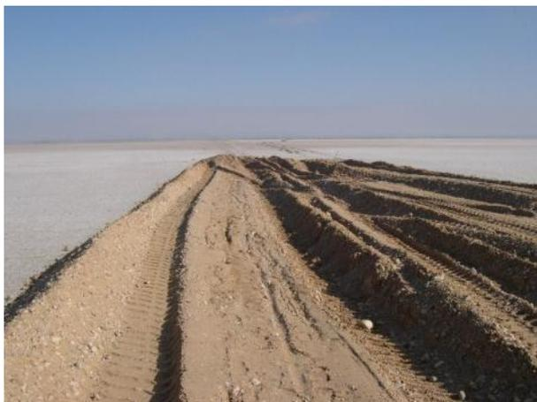
**Figure 4.14** Visualisation des difficultés de mise en place de la première couche du remblai sans géotextile
