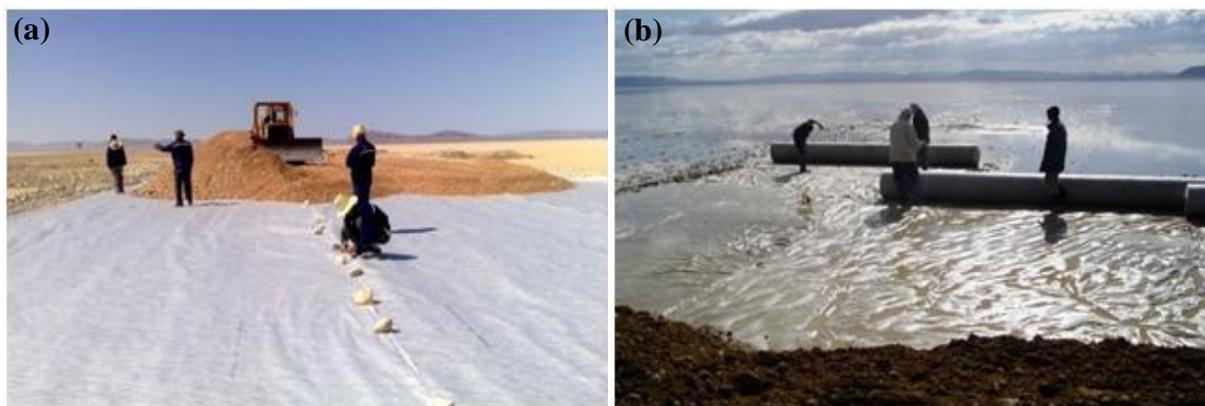
**Figure 4.19** Pose de nappe de géotextile directement sur le sol de sebkha : (a) état sec ; (b) état inondé
