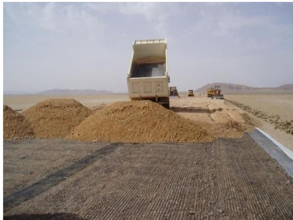
Figure 4.31 Pose de la deuxième couche du remblai
