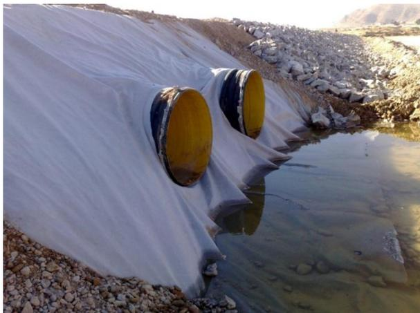
**Figure 4.25** Visualisation de la pose du géotextile sur les têtes des tubes
