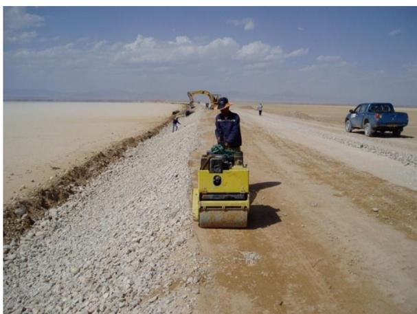
**Figure 4.26** Visualisation de la première couche d'engrochement inférieure à 10 cm
