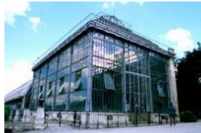
Figure I. 8: Serres du jardin des plantes, Paris, 1833, Architecte : Rohaut de Fleury (Source: http://www.crit.archi.fr )
