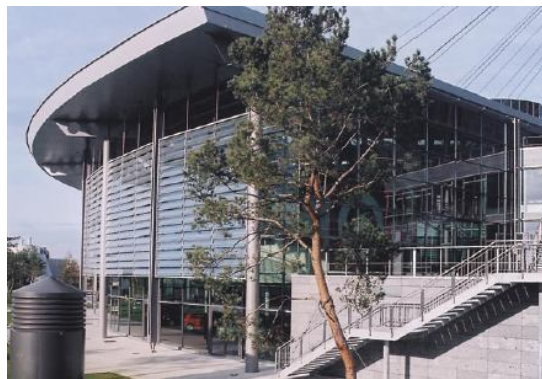
Figure I.65: Brise soleil à lames de verre en position entièrement fermée Source : www.Colt-France.fr
