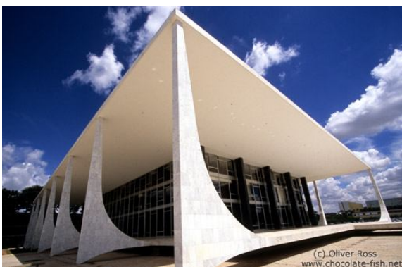
Figure I.76: Bâtiment de court suprême, Brasilia 1957, Architecte : Oscar Niemeyer (Sourcec : http://www.batiactu.com )
