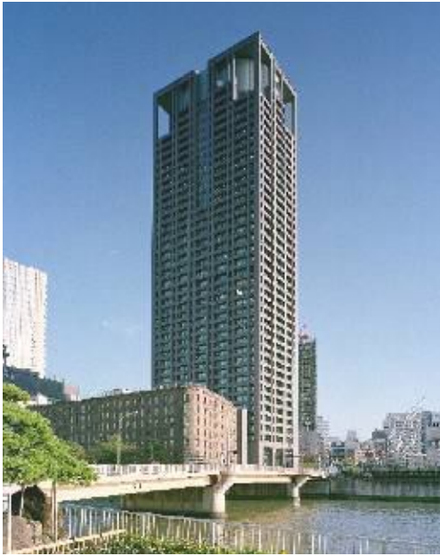
Figure I.59 : le bâtiment de Kansai Electric ,2005 ,Osaka, Japan ,Architecte : Nikken Sekkei . (Source : M.Yamagiwa,2006).
