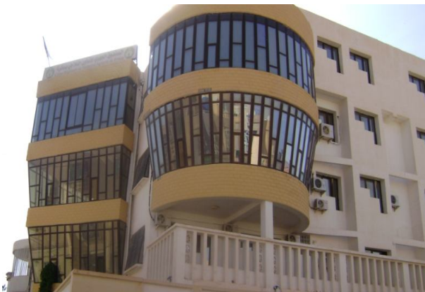
Figure I.108: Le bâtiment de la Caisse Régionale de la Mutualité Agricole ,Biskra (Source : Auteur,2011)
