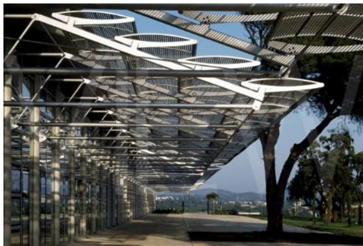
Figure I.55 : système de protection solaire, Lycée Polyvalent de Fréjus en France, (Source: http://www.viewpictures.co.uk )
