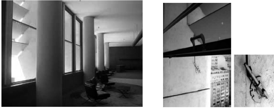
Figure I.75: Brise-soleil avec des lames horizontales mobiles pour bloquer les radiations solaires indésirables. (Source : J. Manuel Melendo, 2008)
