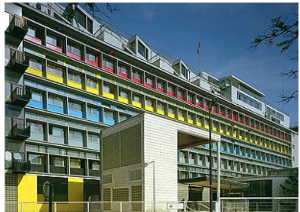
Figure I.39 : la Cité-refuge de l'Armée du Salut ,1952, (rénovation de la facade) Source: http://www.culture.gouv.fr
