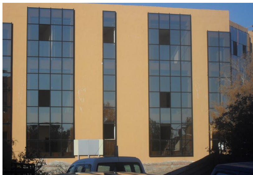
Figure I.107: Extension de l'Hôtel des Finances, Bechar (Source : Auteur,2012)
