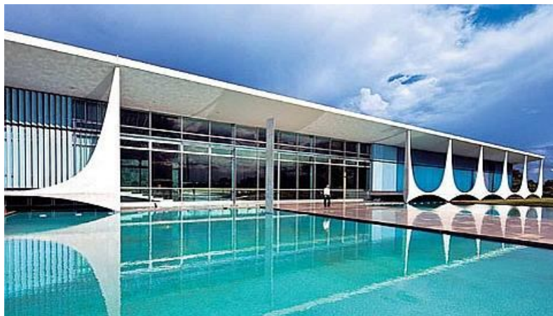
Figure III.15 : Les débordements latéraux, du palais d'Alvorada .Oscar Niemeyer (Source: http://www.lefigaro.fr )
