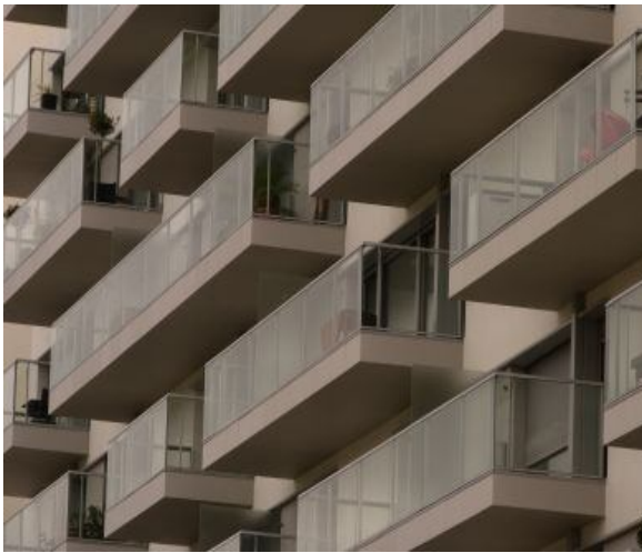
Figure III.13 : Les balcons, element d'ombrage (source : www.muides.over-blog.com )
