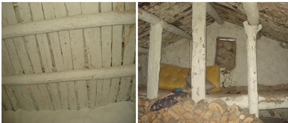
Figure I. 33 : Le toit (s'qef) : village de Bou-Mansour, (Source : auteur 2012)
