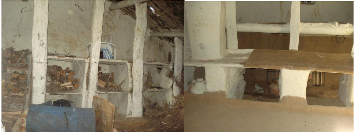
Figure I. 30 : A gauche : Lekdar ou (adekkwan), à droite Tadekwant, cas du village de Bou-Mansour. (Source : Auteur, 2012)
