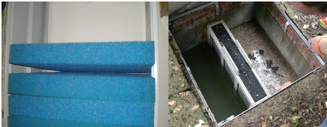
Figure 6.5: Photos représentant le filtre de finition, composé d'un porte filtre et une éponge, avant et après utilisation.
