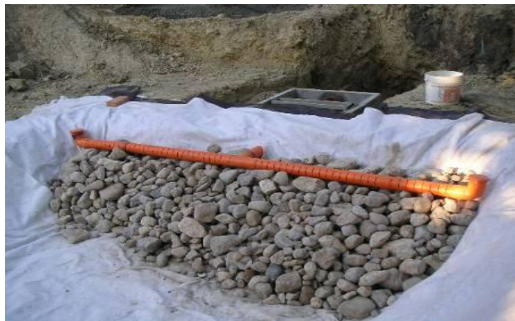
Figure 4.4 : Photo. d'une conduite perforée pour la distribution sous-superficielle.
