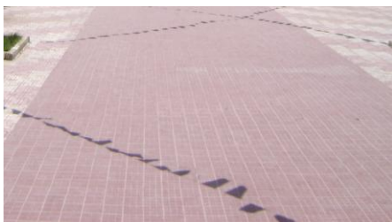
Photo 6.7 : Revêtement du sol de la place du théâtre. Source : Auteur (2011).
