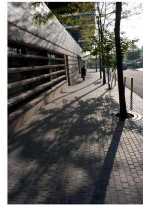
**Figure II. 26 : Surface réfléchissante : dallage brillant (Source : Archiref, 2010)**
