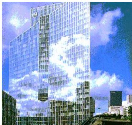
**Figure II. 27 : Bâtiment avec vitrage réfléchissant (Source : Energie +, 2011)**
