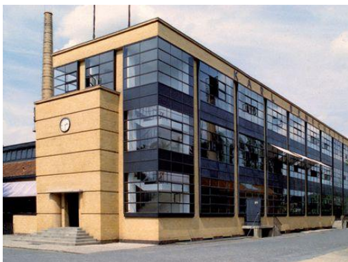
Figure IV. 11 : Le mur rideau et vue intérieure des parois transparentes d'un bureau de l'usine Fagus. (Source : WHC.UNESCO, 2010)
