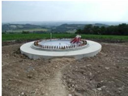
Figure II.3 : la fondation l'éolienne.
