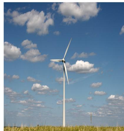
Figure I.1: Éolien à axe horizontal
