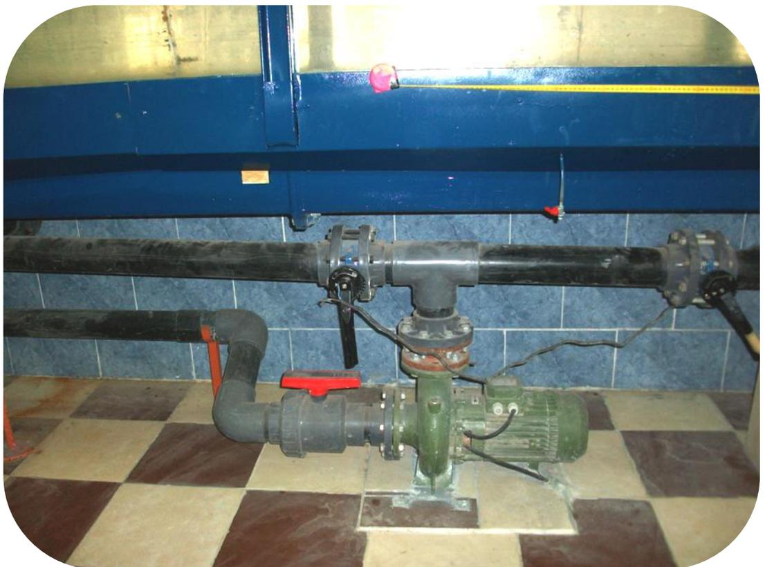
*Figure 1.3 : Pompe centrifuge axiale*
