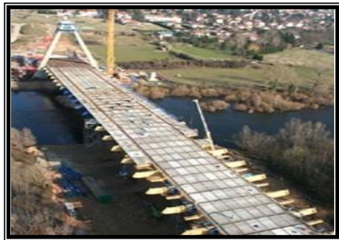
Ouvrages d'arts ponts (tabliers),
