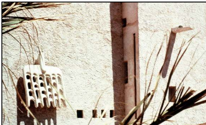
الصورة (13-II): كاسرات الشمس والجدران المزدوجة للتقليل من الحرارة. المصدر: المؤتمر الدولي للعمارة والمناخ، ديسمبر 2007.
