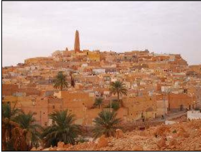
الصورة (10-I): منظر عام لقصر غرداية بالصحراء الجزائرية.
