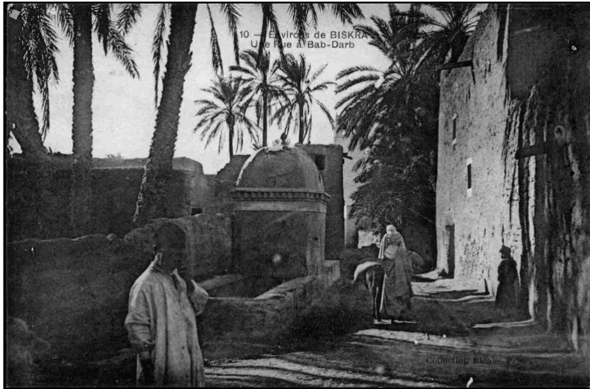
الصورة (1-V): صورة لواجهة أحد المنازل بباب الدرب- بسكرة القديمة-
