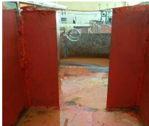
Figure 6.4 : Photographie d'un déversoir rectangulaire sans hauteur de pelle avec contraction latérale ayant servi à l'étalonnage du débitmètre à diaphragme
