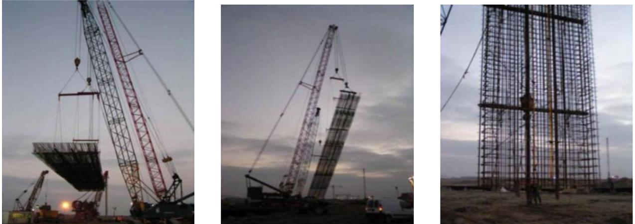
Figure VI.71. Transport de la cage d'armature. D'après (Marten, 2005).
