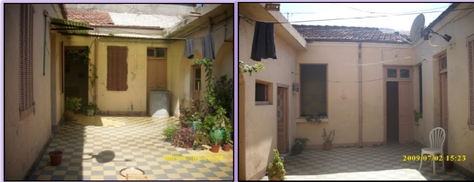
Photo-VII.3 : vues sur le patio
