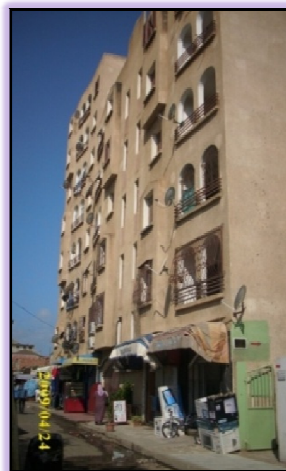
Photo-VI.9: Bâtiment type collectif récent
