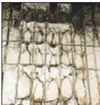
Photo 1.8 : Dégradation causé par incendie
