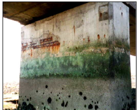
Pile en zone de marnage
