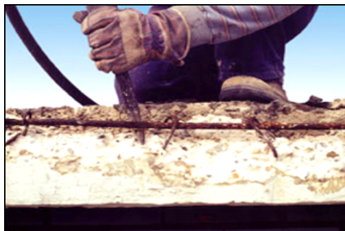
Photo 1.14 : Enlèvement des aciers corrodés
