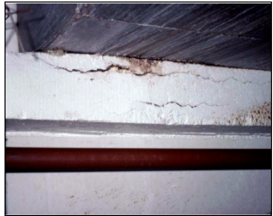
Poutre support de réservoir
