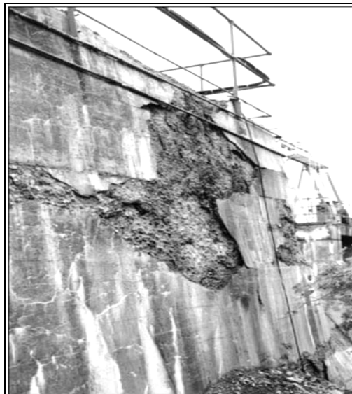
Photo 1.1 : Exemple de dommages causés par le gel-dégel
