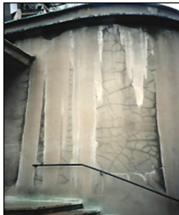
Photo 1.7 : Faïençage lié à une attaque sulfatique
