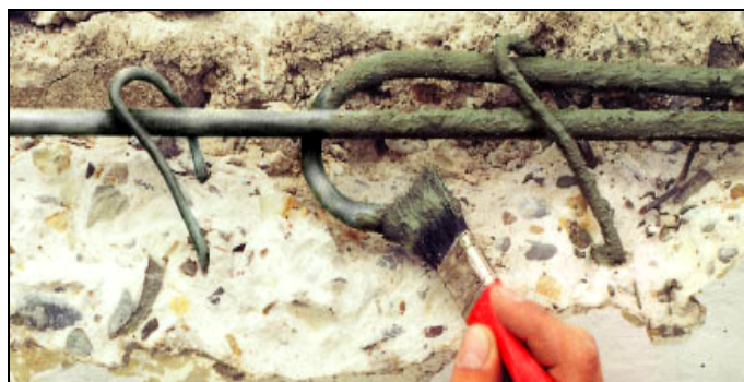
Photo 1.13 : Nettoyage de la surface
