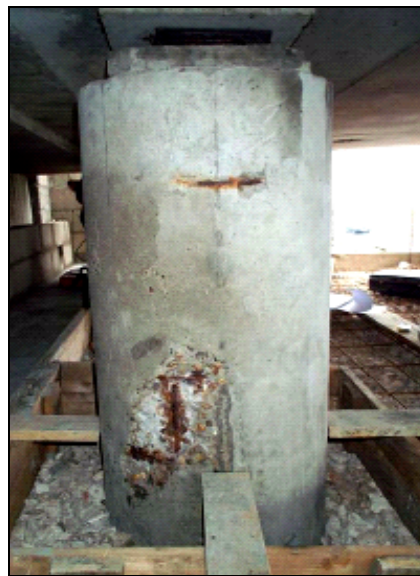
Pile de pont
