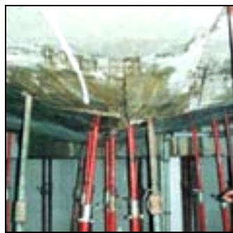
Photo 1.9 : Dégradation causé par surcharge
