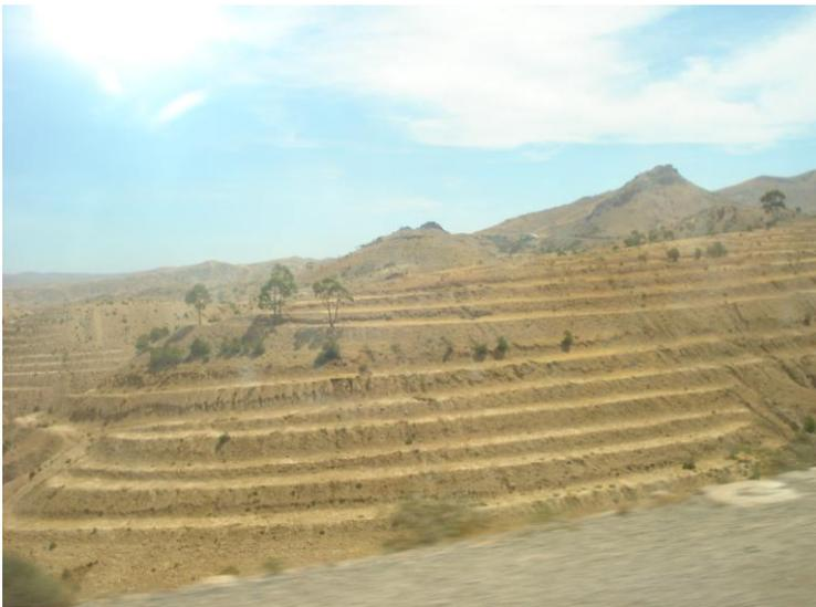
**Fig. 1.23. Banquettes réalisées au niveau du bassin versant de l'oued Mina (Remini, 2011)**
