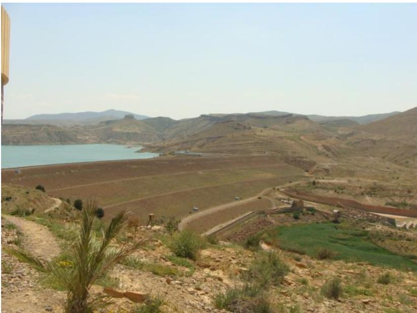
Fig.3. 2. Vue générale de la digue en enrochement (Remini, 2013)
