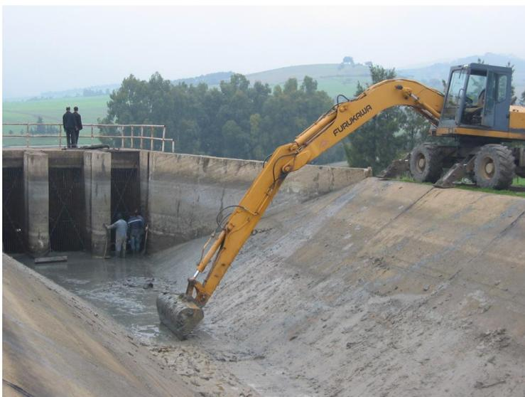
**Fig. 1.19. Curage d'un canal par les moyens mécaniques (OPIM, 2008).**
