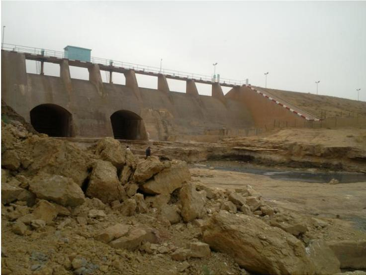
**Fig.I. 25 : Deux vannes de fond du barrage de Boughezoul (Remini, 2011)**
