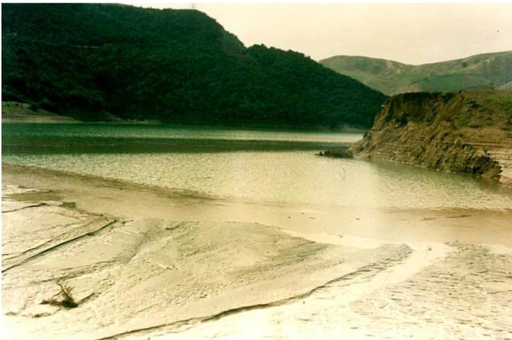
Fig. 1.16. Envasement du barrage d'Ighil Emda (Remini et Ouaret, 2004)
