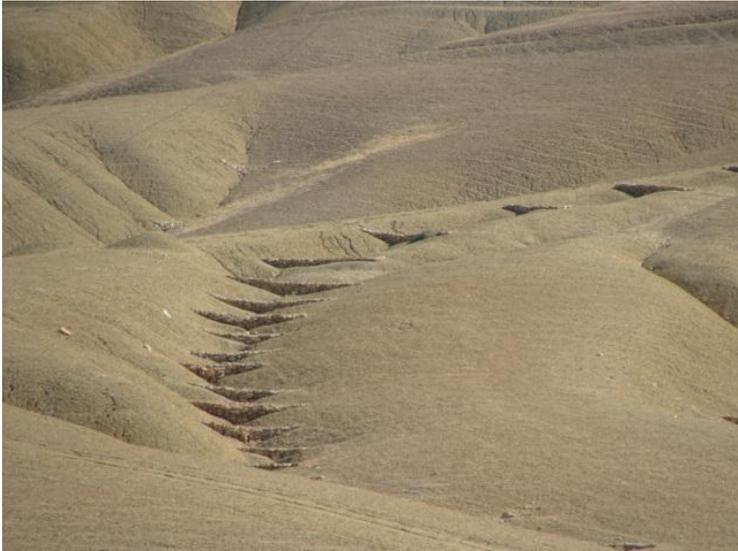
**Fig. 1.22. Une série de seuils réalisées sur une ravine du bassin versant de Beni Chougrane (Remini, 2011)**
