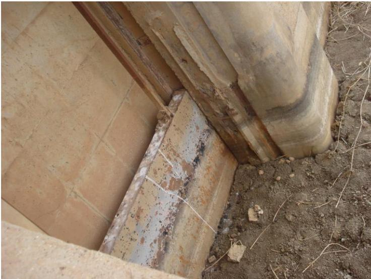
Fig.1.18. Blocage des vannes de fond (Remini, 2011)
