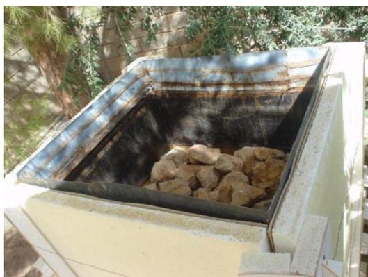
**Fig.III.18.** *Vue sur la toiture radio-évaporative (Bencheikh, 2007)*
