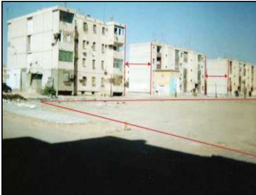
الصورة (V-5): صورة توضح تباعد الأجنحة وصعوبة التنقل داخل الحي
