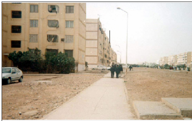
Fig.5 : Logements collectifs des 500 logts.
