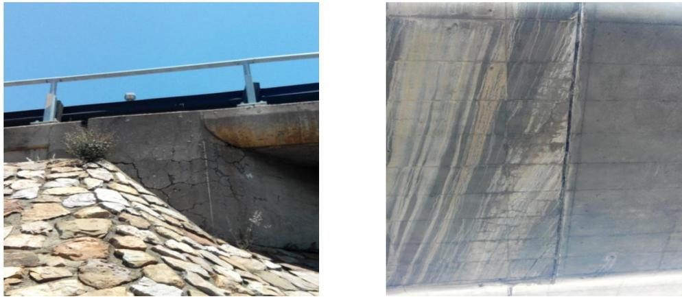
Fig.1.III.2 : Endommagement de la culé par apparition de fissuration  $>25$  mm d'ouvertures sur le pont Golden à Jobourg, Sud Afrique, et l'image de droite montre des fissurations au joints de deux voussoirs.
