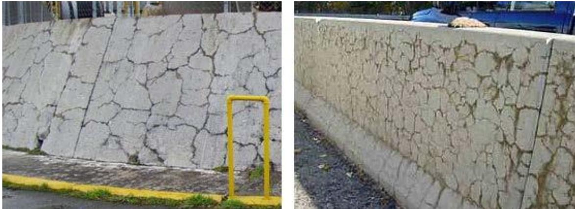
Fig.1.III.3 : L'image de gauche est une structure auxiliaire au barrage Belesar en Espagne, et l'image de droite montre le modèle de fissures caractéristique affectant une barrière de sécurité sur une autoroute aux États-Unis. [Winter.2001]
