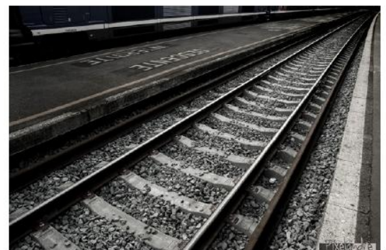
(b) Contrôle de rails, (Rails).
