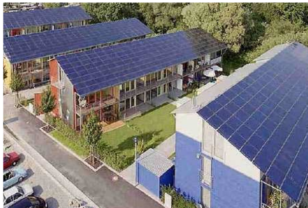
Figure I.4 exemples de bâtiments à énergie positive à Freiburg en Allemagne. (Source : greenlineblog.com)
