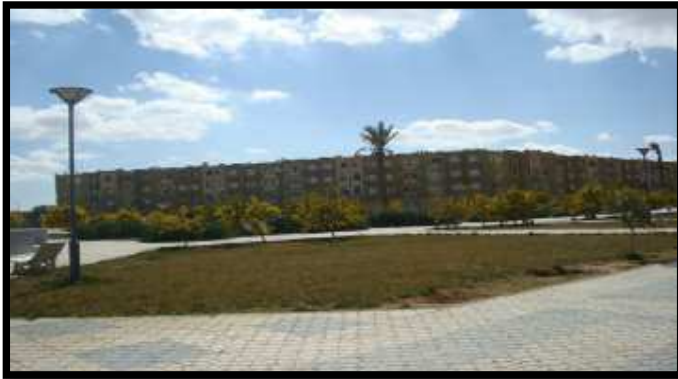
Figure IV.73 : photo générale. Source : auteur 2015
