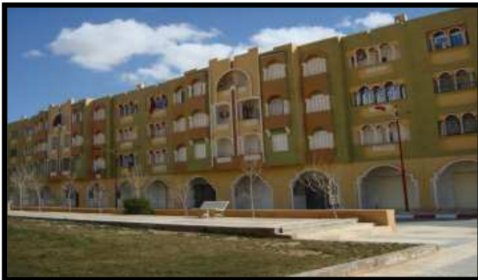
Figure IV.74 : photo sur le bloc de rive. Source : auteur 2015
