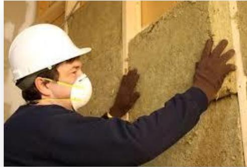
Figure 25: application d'une isolation intérieure source <http://www.finexto.com/>
