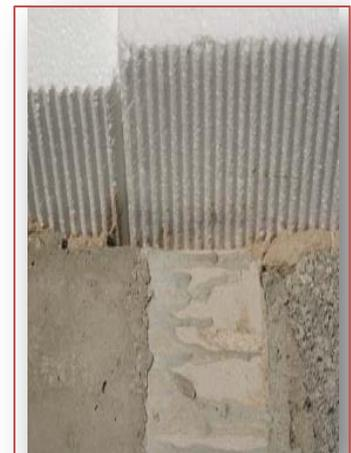
**Figure 57: Les blocs de coffrage isolant.**
