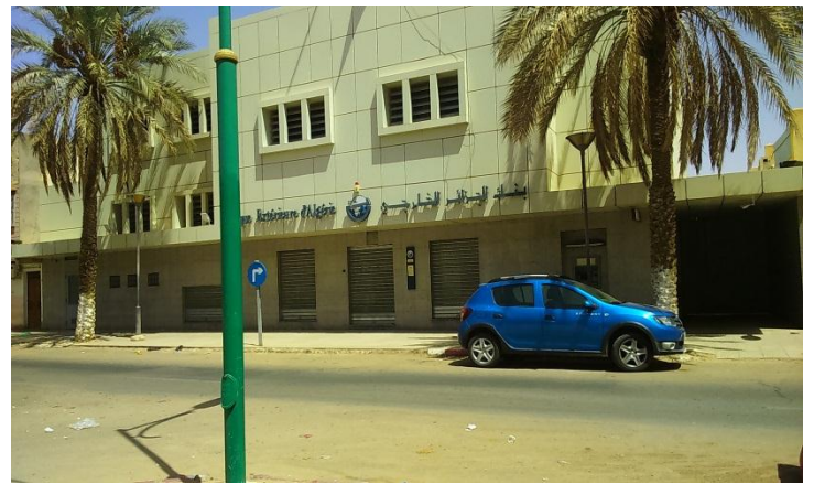
Fig. 4.10 : Bâtiment public critiqué OPVM (BEA- Ghardaia)
