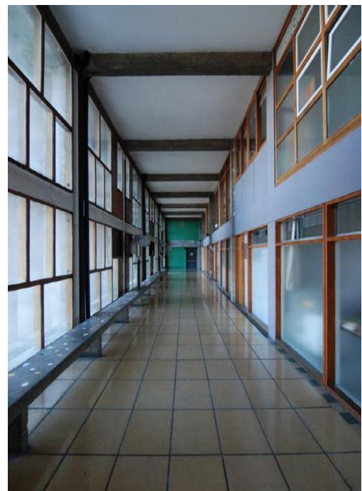
Fig. 2.6 : ouvertures, sièges et éléments structuraux sur la «rue commerçante» interne sont régies par le système de Modulor
