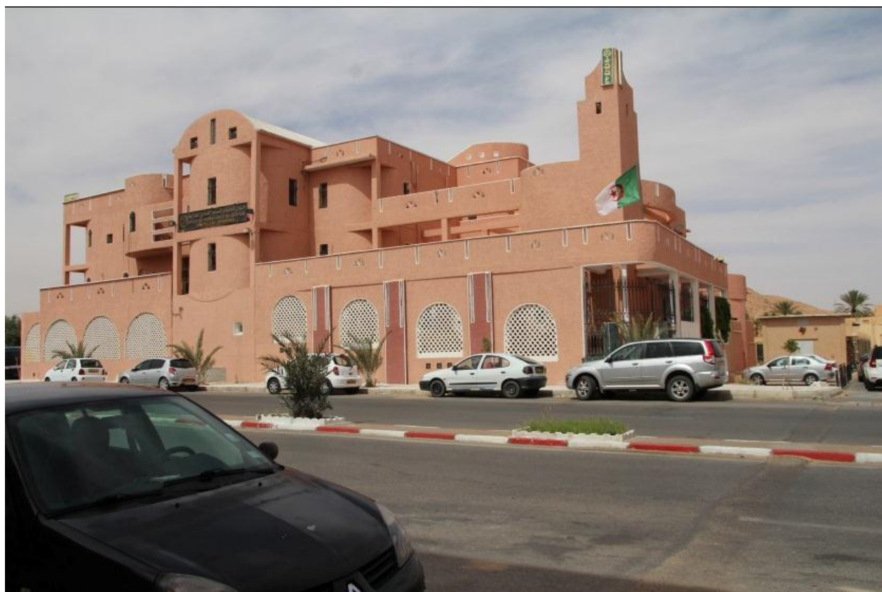
Fig. 4.15: vue d'extérieur sur le bâtiment objet d'étude
