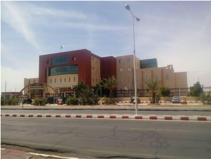
Fig. 4.9 : Bâtiment public critiqué OPVM (cour de justice- Ghardaia)
