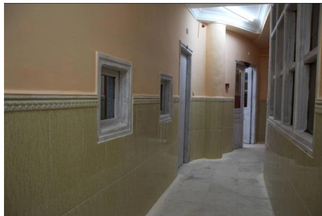
Fig. A.7 : Rénovation de l'espace intérieur
