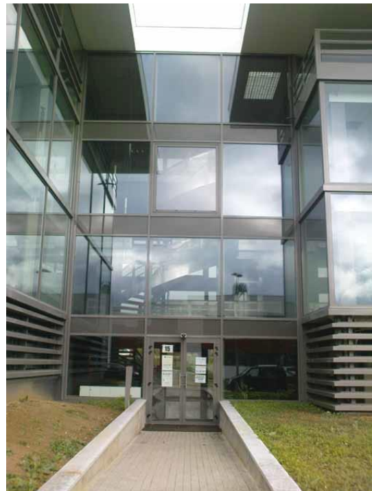
Fig. 2.3 : Porte principale avec système de détection, très onéreuse, a l'avantage de faciliter l'accès aux personnes à mobilité réduite.
