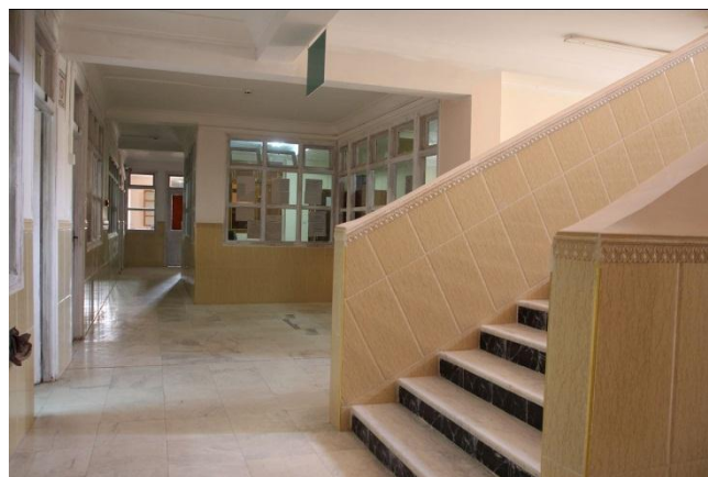
Fig. A.11 : Rénovation de l'espace intérieur
