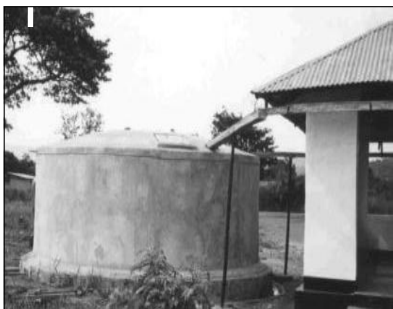
Figure 2.4: Un système domestique de 8m 3 de récupération en Sri Lanka Source (Turner, 2000)
