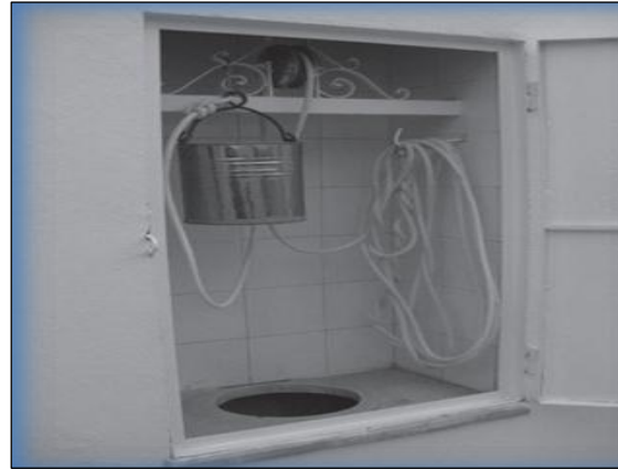
Figure 1.3 : Dispositif de puisement de l'eau de pluie collectée dans un Majel dans une villa moderne de Sfax (Verdeil, 2007)
