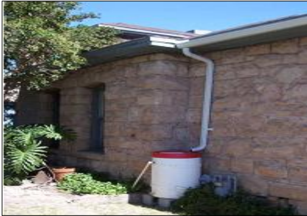
Figure 1.2 : Exemple d'un système de collection des eaux de pluie (Texas Water Development Board, 2005)
