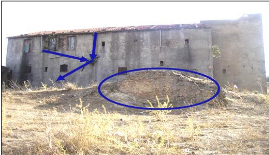
Figure 1.1: cuve de stockage des eaux de pluie abandonnée Ferme Botoz à Souk-Ahras.
