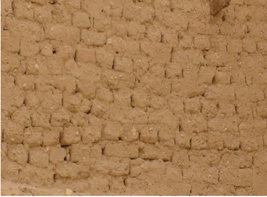
صورة رقم 14: توضّح مادة الطّوب الممزوجة بالحصى.
