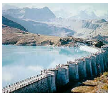
Figure 4 : Schéma et photo d'un barrage contreforts (Site web. 2).
