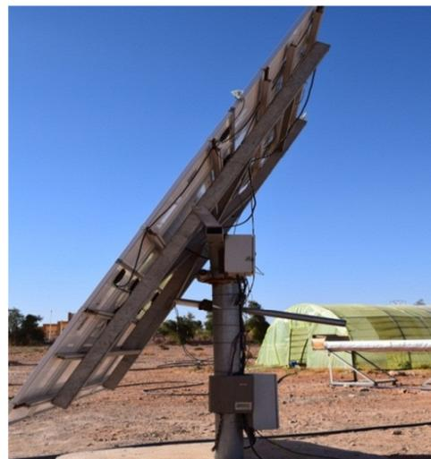
**Figure I.19.** Le suiveur du soleil DEGER tracker 3000 NT installé à l'URAER
