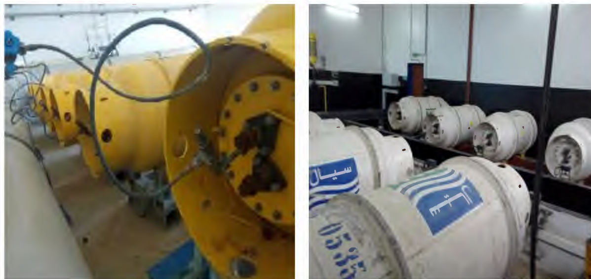
Figure 58: Le système de chloration avec les tanks à chlore gazeux utilisé dans quelques stations (A droite la station de Boudouaou ; à gauche la station d'Oued Athmenia)
