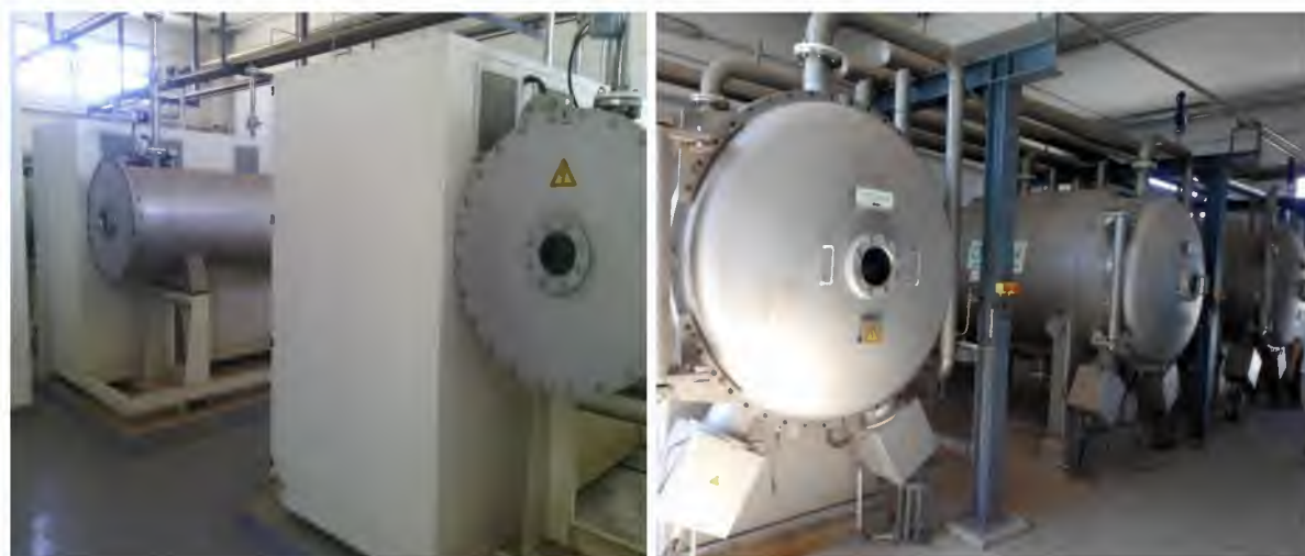
Figure 59 : Les générateurs d'ozone utilisés dans quelque station (A droite station d'Oued Athmenia , à gauche la station de Aïn Tinn)
