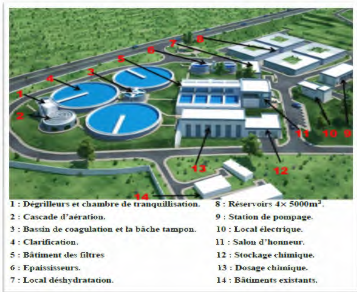
Figure 32: Les procédés de traitement dans la station de Kissir (Hemimed, 2016)
